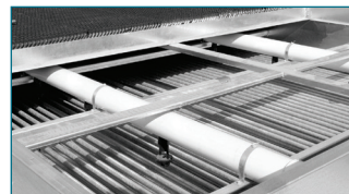
可移开脱水器来检修盘管
