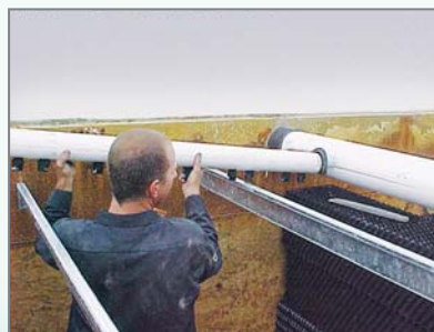
水分配系统和逆流塔填料
