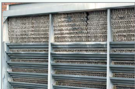
陈旧、低效、破损的填料
