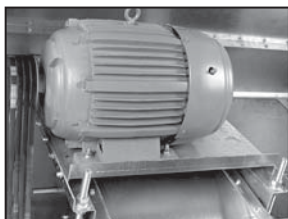
Example LSWE Fan Motor Mount
